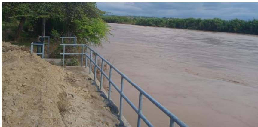
FIGURA N°03: EN LA TEMPORADA DE MAXIMAS AVENIDAS, EL RÍO TUMBES SE DESBORDA EN ESTE TRAMO LLEGANDO A NIVELES QUE SOBREPASAN LA BARANDA Y AFECTA LOS EQUIPOS DE BOMBEO DE ESTA CASETA QUE ENCUENTRA A SU PASO.
